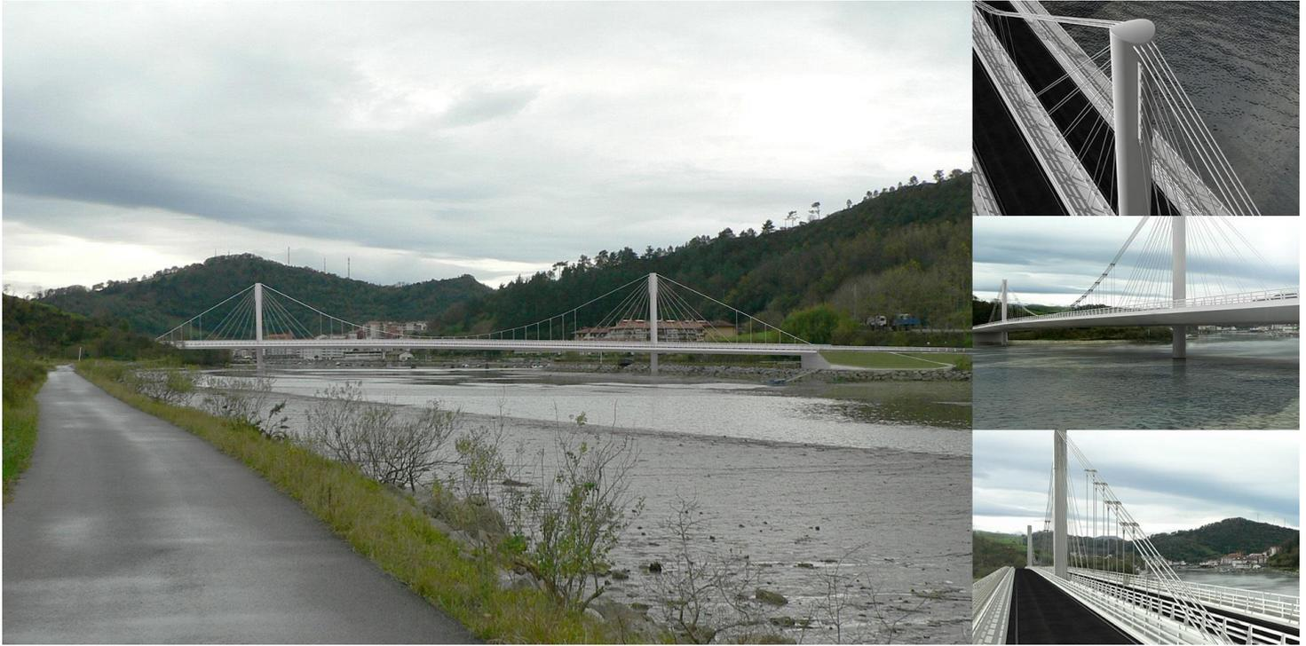
El puente que cruza la ría del Orio es una estructura con un sistema de sustentación híbrido, que combina un sistema de suspensión con otro de atirantamiento, con objeto de disminuir la altura de las pilas y no producir una estructura excesivamente intrusiva en el paisaje, disminuyendo al mismo tiempo los costes frente a un puente colgante clásico. El puente presenta una luz principal de 170 m con sendos vanos de compensación de 60 m, salvando ampliamente el canal del campo de regatas.
